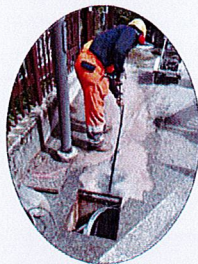
Esempio di nuovo scavo in tecnica di microtrincea
