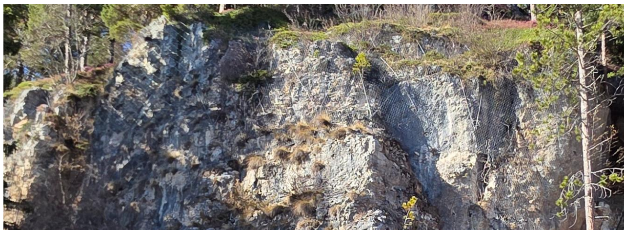
Foto 28: vista della parete nella parte superiore rivestita
