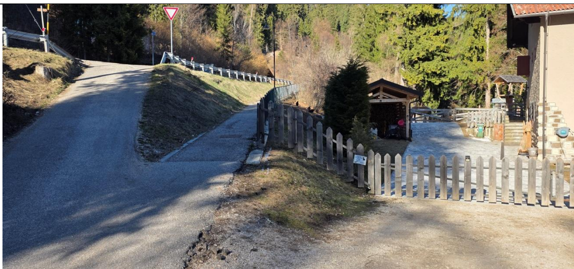
Foto 29: variante 39 con l'area in primo piano oggetto di regolarizzazione
