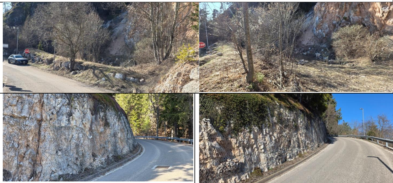
Foto 1-4: Vista dell'area di Variante con la viabilità esistente; strada che sale ai Villini dell'Alpe. Nella foto 1 e 2 si vede che la strada è protetta da un vallo-tomo in terra con scogliere. La parete si colloca a qualche decina di metri dalla strada. Nelle foto 3-4 (23M) si vede la parete che fiancheggia la strada protetta con rete doppia torsione.
