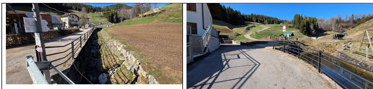
Foto 5-6: vista da valle della situazione esistente con la strada che fiancheggia la sponda dx del rio che si presenta regimato con alveo artificiale per tutta la lunghezza
