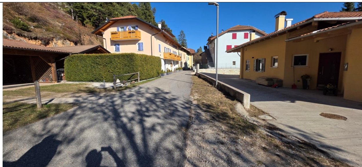
Foto 28: variante 38G a sx e 38H a dx che prevede la regolarizzazione dello stato di fatto in primo piano
