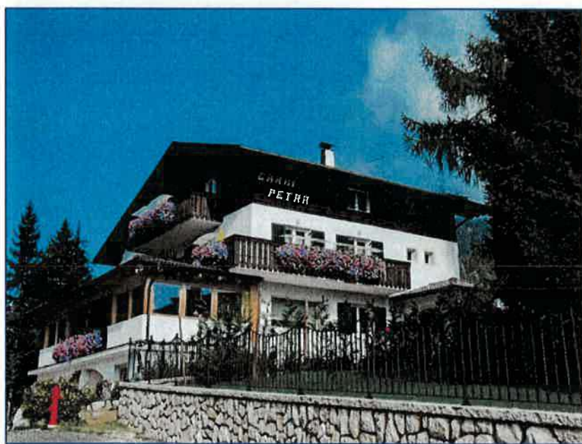
Vista esterna edificio in oggetto
