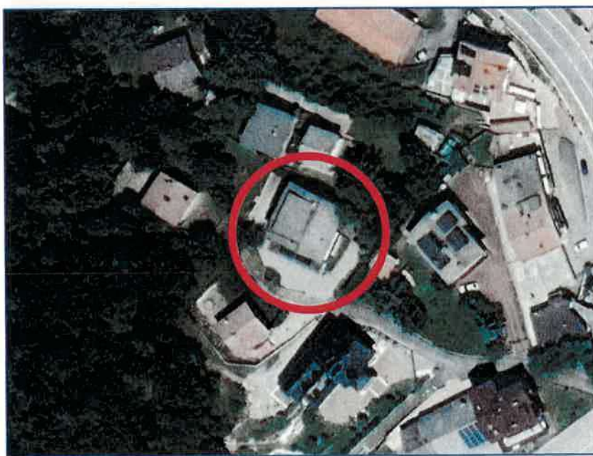
Ortofoto edificio in oggetto
